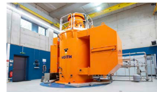
Eine Pelton-Turbine und ein Generator mit einem sehr hohen Wirkungsgrad wandeln die Energie des Wassers in elektrischen Strom um.
