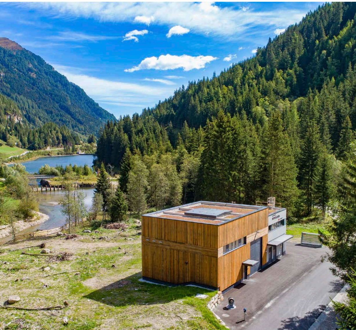
Das Herzstück des Kraftwerkes Rotgülden ist das 2022 neu errichtete Krafthaus.
