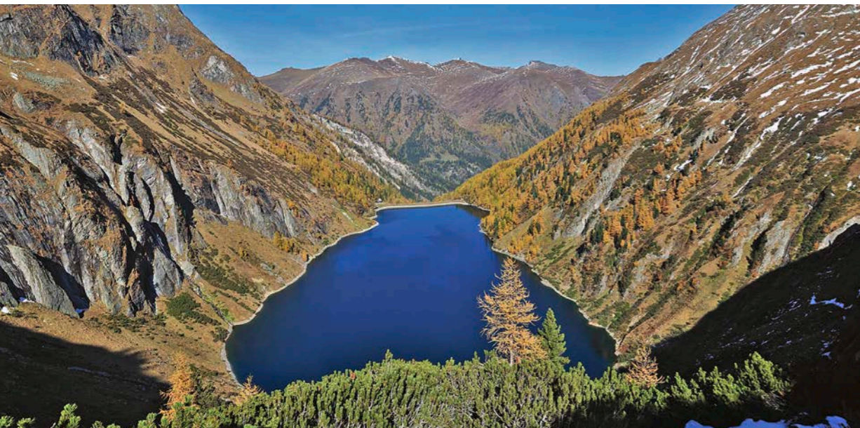
Das Kraftwerk Hintermuhr nutzt Wasser aus dem Rotgüldensee, dem oberen Mur-, Muritzen- und Altenbergtal.
