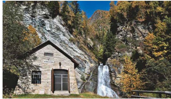
Heute ist das Kraftwerk Murfall mit 780 Kilowatt Leistung ein Kleinwasserkraftwerk.
