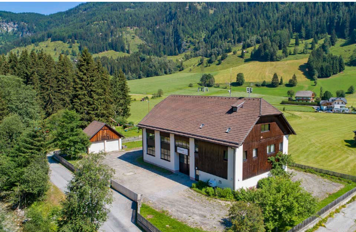
Das Krafthaus liegt nördlich von Zederhaus, neben Zederhausbach und Tauernautobahn.
