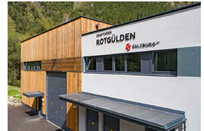
Das neue Krafthaus vom Wasserkraftwerk Rotgülden.
